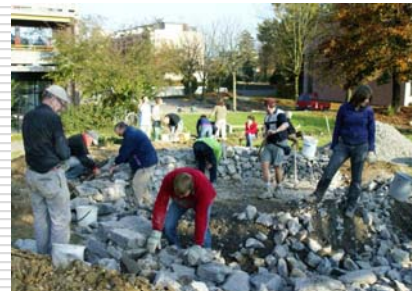
Bau Trockenmauer
